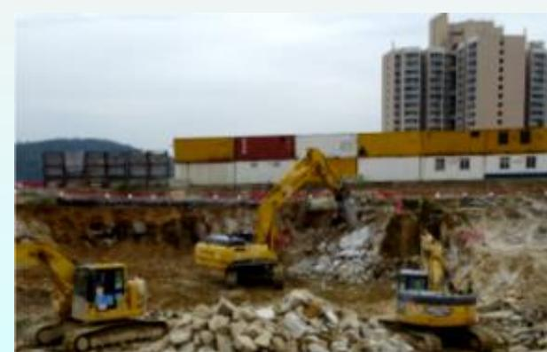
除了在工地設置隔音屏障外，更在打石工程範圍與附近民居之間放置貨櫃作隔音之用，可有效減輕工程噪音。
